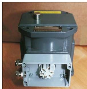
Anschlussseite der Aderleitungsdurchführung mit Klemme
